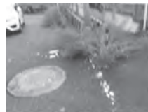
清水地下道北出口(清掃前)
